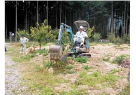
写真3 油圧ショベルによる株ゆるめ
